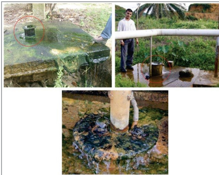
Foto 2: Telaga penghasilan lama yang masih menghasilkan telaga artesian walaupun sistem pam sudah tidak berfungsi. Lokaliti telaga ditandakan pada Rajah 1 sebagai telaga eksplorasi yang berhampiran stesen survei G2.
