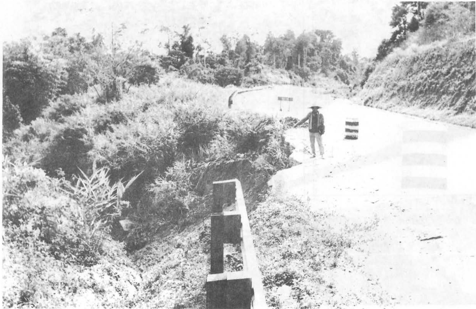
Fotograf 1: Gelinciran dalam pada cerun tambakan (T1-b) di lokasi 65.5S.
